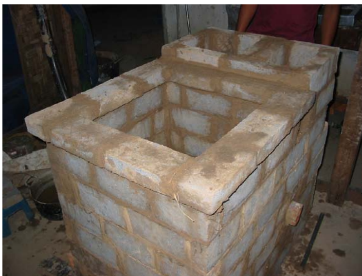
Figure 14 : Four à haute performance en construction (expérience au Cambodge)
